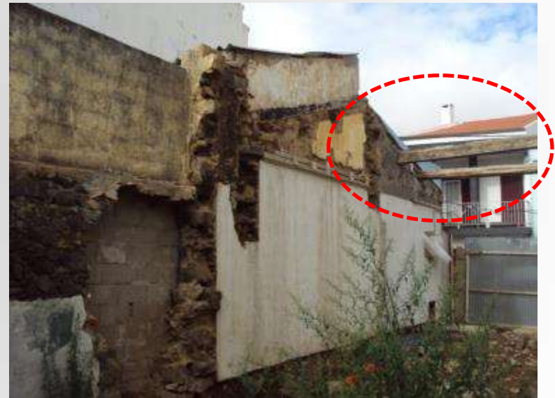
Descalce de fundação de moradia, em obra de demolição e reconstrução.
