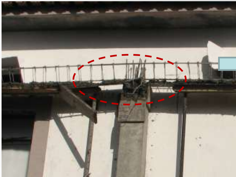
Amarração de aço no topo de pilar, na altura da betonagem.
