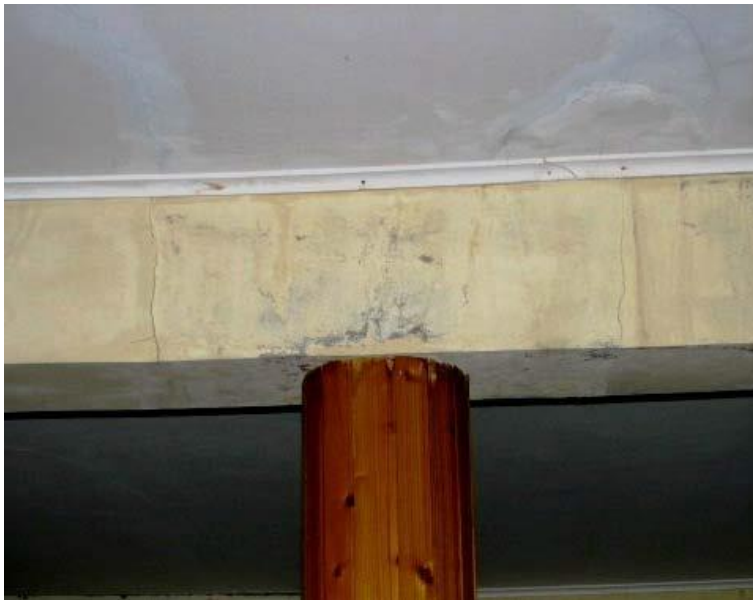
a) Pilar de recurso colocado para contrariar a deformação da viga.
