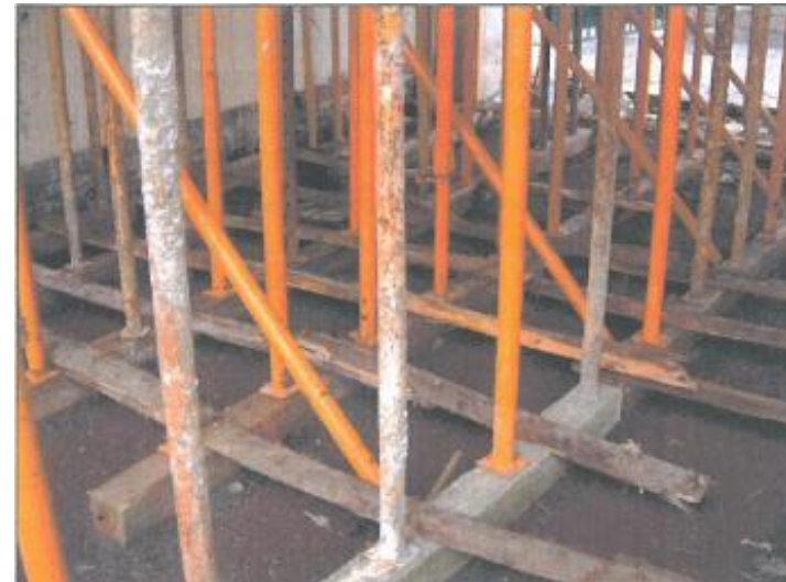
b) Escoramento antes da nova betonagem.
