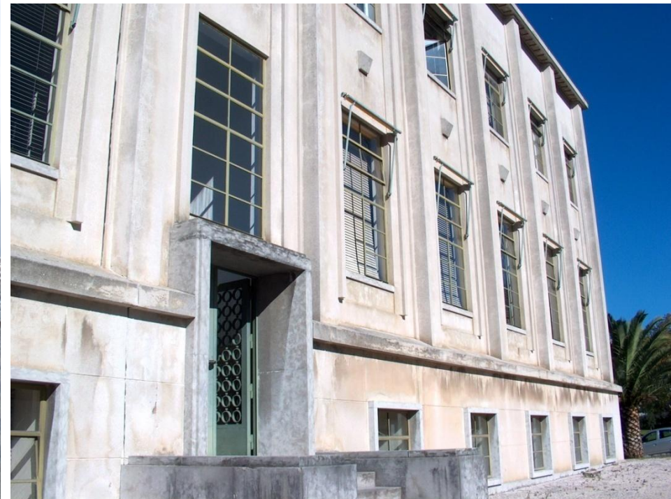
Edifício Principal do LNEC, Lisboa, 1956
